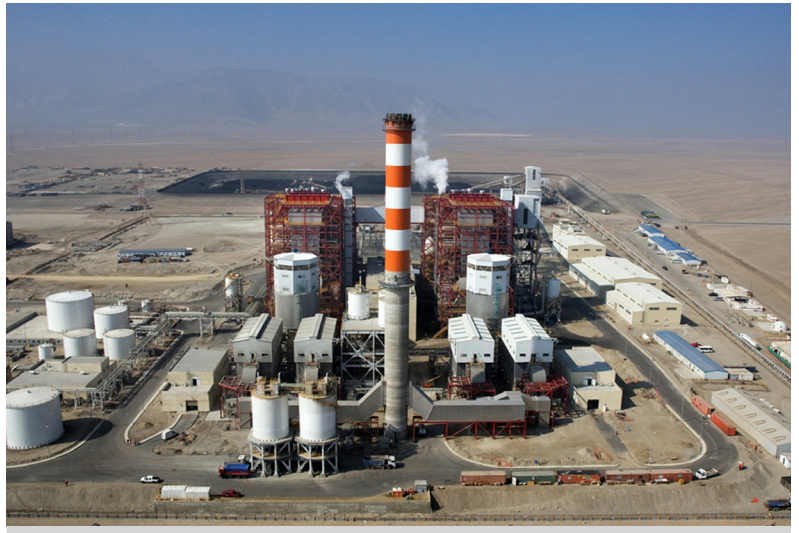
La central eléctrica Punta Catalina de la República Dominicana. (Fuente Desconocida)
